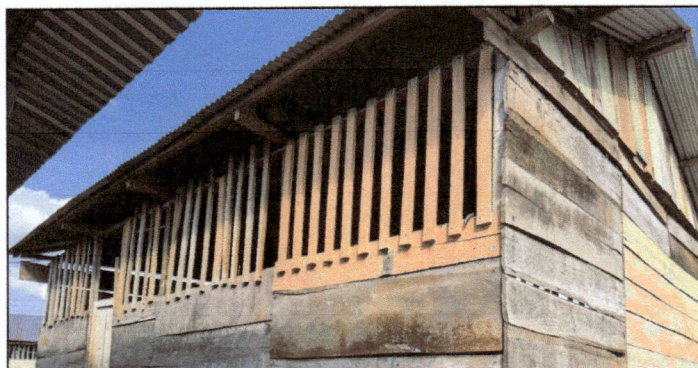
Foto 5: Vista de las ventanas de madera de las aulas del centro educativo. Se sustituirán por balcones de metal para poder dar iluminación y ventilación a los niños dentro del aula.
