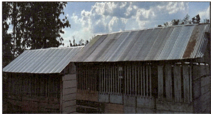
Foto 4: Se observa la necesidad de sustituir los balcones de madera por balcones de metal. También la reparación de la estructura de techo y cubierta de lámina.
