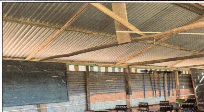
Foto 2: Se observa el deterioro de la estructura de techo de madera y la necesidad de instalación de ventanas en las aulas.
